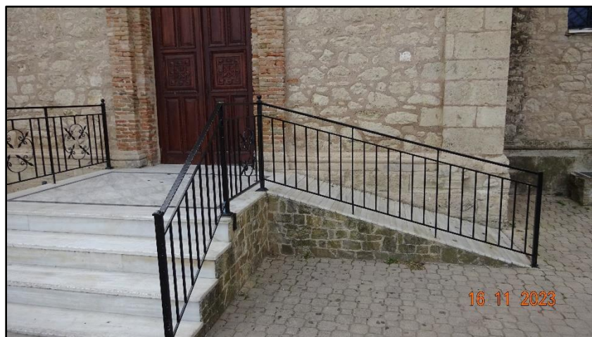
Εικόνα 21 (Ξυλόκαστρο) : Ιερός Ναός Αγίου Βλασίου με ράμπα πρόσβασης η οποία όμως δεν πληροί τις προδιαγραφές κλίσης για την πρόσβαση του αναπηρικού αμαξιδίου.
