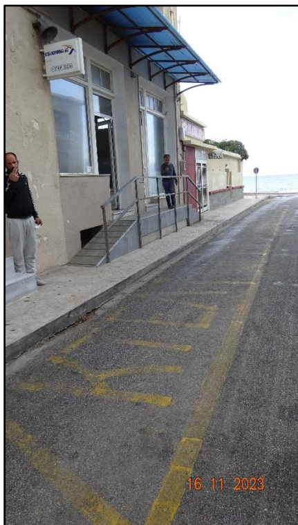
Εικόνες 22-23 (Ξυλόκαστρο) : Εκτός προδιαγραφών ή εμποδιζόμενες ράμπες πρόσβασης στο ΚΤΕΛ και στο ΚΕΠ Ξυλοκάστρου.
