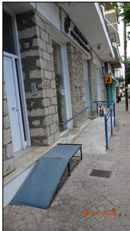
Εικόνες 22-23 (Ξυλόκαστρο) : Εκτός προδιαγραφών ή εμποδιζόμενες ράμπες πρόσβασης στο ΚΤΕΛ και στο ΚΕΠ Ξυλοκάστρου.
