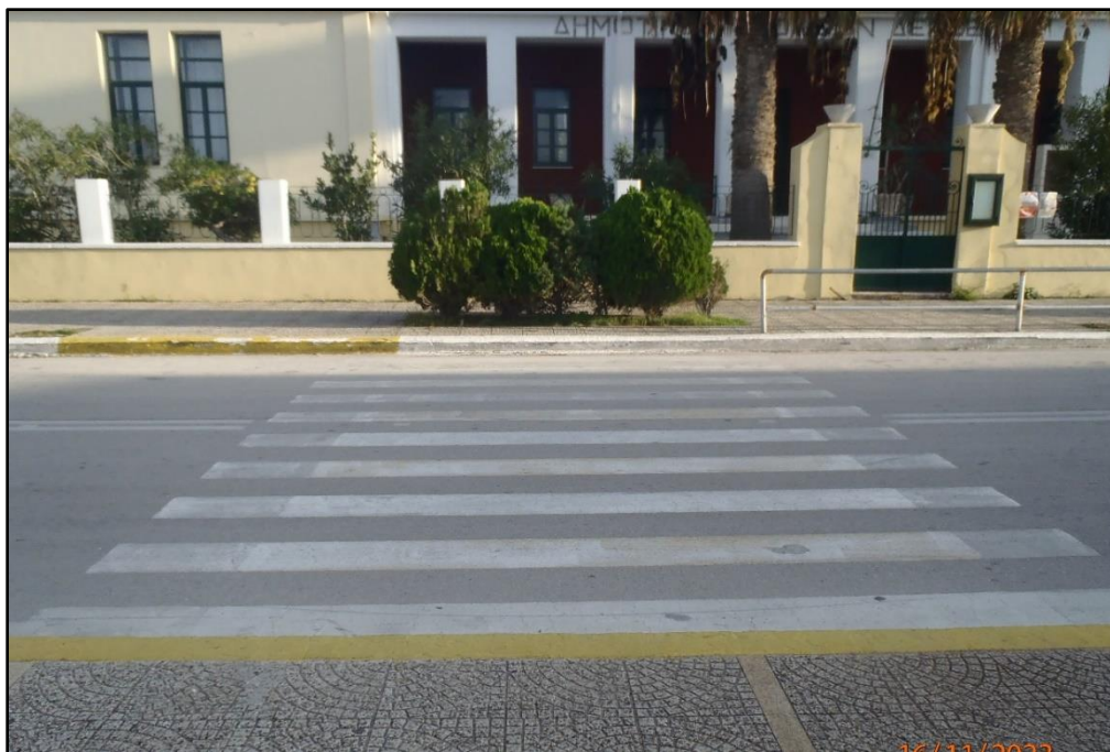
Εικόνα 38 (Δερβένι) :Διάβαση πεζών χωρίς ράμπα διέλευσης αναπηρικών αμαξιδίων και με φύτευση στην μία της πλευρά που εμποδίζει την πρόσβαση.
